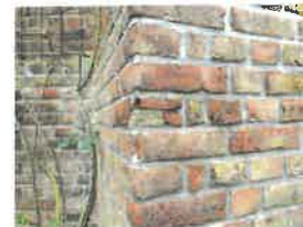
80 - Rejointolement au mortier de ciment et ragréage d'une brique pour combler une lacune sur le soubassement du pan axial du chevet
