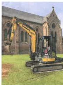
Figure 22 : Pelte mécanique utilisée pour les sondages
