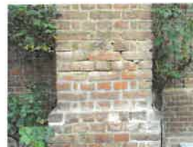
65 - Vidage des joints de parement, partiellement repris, en partie basse du contrefort entre la deuxième et la troisième travées de l'élévation Sud de la nef
