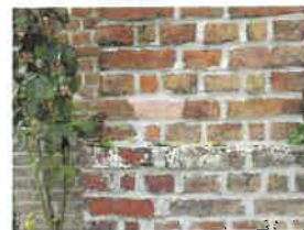
81 - Rejointolement au mortier de ciment du soubassement du contrefort oriental du croisillon Sud et réparation d'une brique avec un mortier de couleur rose pale intégrant peut-être une chamotte (brique pilée ou pigments minéraux)
