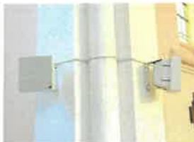
32 - Enceintes implantées sur les piliers de la nef, des croisillons et du chœur
