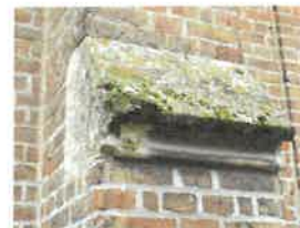
61 - Lacune sur le ressaut (en pierre ?) du contrefort Ouest du pignon du croisillon Sud
