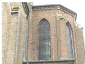
84 - Reprise d'une partie de l'encadrement de la baie de l'élevation Nord du chevet en briques modernes
