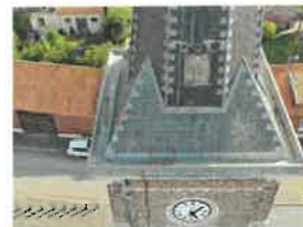
95 & 96 - Mouvements d'ardoises en versants Nord et Sud de la base de la flèche du clocher image Maîtré de Glisy - 13 septembre 2021
