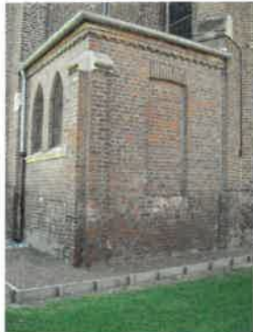
La sacristie - Isabelle Barbedor Inventaire général des Hauts-de-France cote : IVR22_20068010155NUCA
