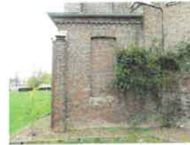
82 - Rejointolement généralisé au mortier de ciment des élévations de la sacristie ; la, l'élévation Ouest
