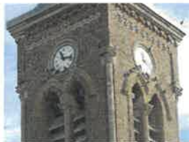
72 - Repos des pigeons sur les oculi d'horloge et sur les archivoltes des baies géminées de la chambre des cloches 9 septembre 2021
