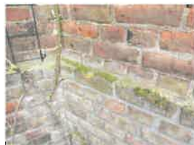
76 - Colonisation par les mousses du soubassement du pan axial du chevet
