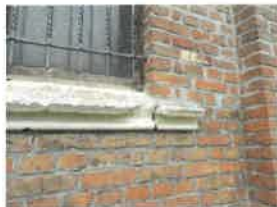
59 - Lacune sur l'appui de la baie géminée en élévation Nord de la sacristie
