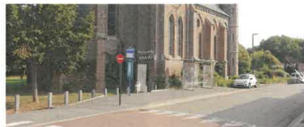
36 - Emplacement de la nouvelle porte d'entrée en élévation Ouest du croisillon Sud
