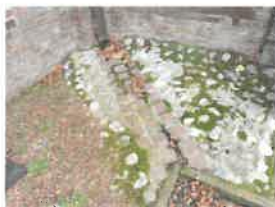
77 - Colonisation par les mousses du caniveau et des revers en galet à l'angle de la nef et du croisillon Nord
