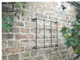
91 - Support pour les rosiers fixés dans la brique
