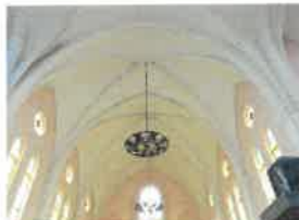
103 - Couvrement de la nef depuis le chœur
