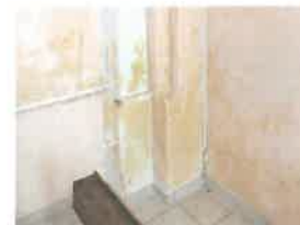
68 & 69 - Efflorescences généralisées aux parties inférieures des élévations de l'église
