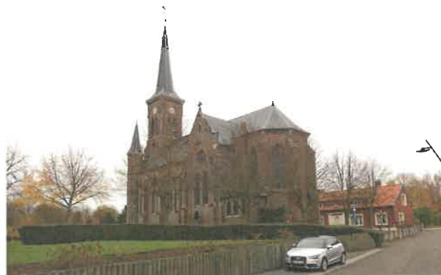
Depuis le Nord-Ouest, le 17 novembre 2020
