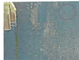
94 - Casse d'ardoise sur le versant Nord de la couverture de la nef image Maîtré de Glisy - 13 septembre 2021
