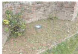
27 - Eclairage monumental au Sud-Ouest du chevet
