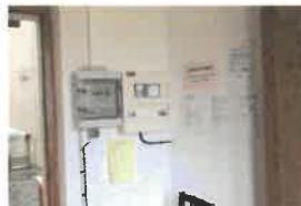
25 - Tableau de protection pour les lustres chauffants dans la sacristie
