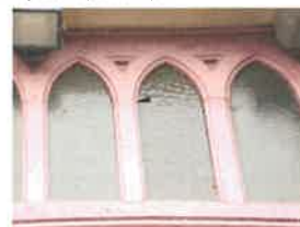
89 - Casses de verres sur l'imposte du portail attribuée à des jets de projectiles
