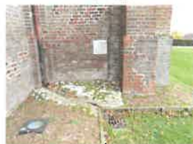
85 - Reprises ponctuelles en briques modernes à l'angle de la nef et du croisillon Nord
