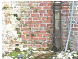
78 & 79 - Traces d'anciennes colonisations des premières travées des élévations Nord et Sud de la nef par le lierre. Des repousses sont observées le long de la gouttière et du coffret EDF au Sud de l'avant nef.
