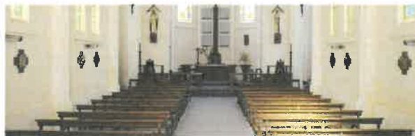
56 - Aperçu du sol de la nef, recouvert d'un tapis sur l'allée centrale, avant la reféction en carrelage Cérame. Les efflorescences sont déjà présentes au-dessus des soubassements. Inventaire général des Hauts-de-France - cote IVR22_20068000310A - n.d.
