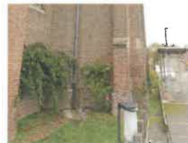
37 - Élévation Ouest du croisillon Nord et abords directs depuis le trottoir de la Rue du Vert Bout
