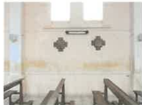
53 - Aperçu des efflorescences au-dessus de la contre-cloison au Nord de la nef
