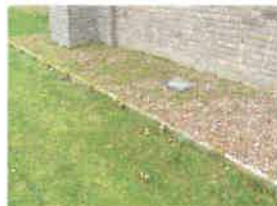
51 - Revers de briques écrasées en pied d'élévations
